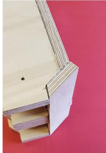
Teil 25 mit den Bohrungen versehen, schräg anschleifen/ einpassen und vorne einkleben.
